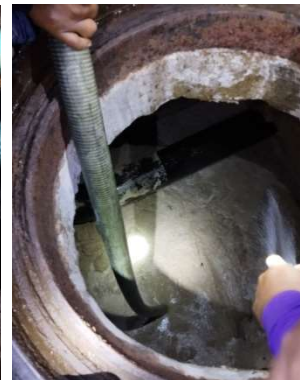
ภาพที่ 4-51 คูตะกอนไขมันและถังเก็บตะกอนในระบบบำบัดน้ำเสีย
