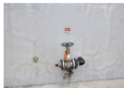
ภาพที่ 4-30 หัวรับน้ำดับเพลิงจากภายนอกส่วนโรงแรม และส่วนสรรพสินค้าพาณิชย์
