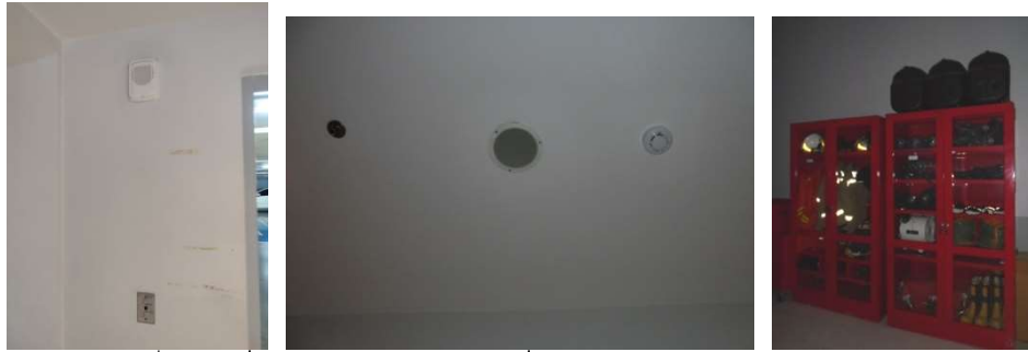
ภาพที่ 4-35 เครื่องแจ้งเหตุโดยใช้น้ำมือดึงและกริ่งสัญญาณเตือนภัย และตู้เก็บชุดผจญเพลิง
