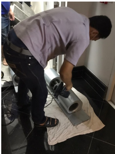
ภาพที่ 4-64 ล้างทำความสะอาดระบบปรับอากาศ และCooling Tower
