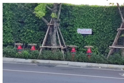
ภาพที่ 4-30 หัวรับน้ำดับเพลิงจากภายนอกส่วนโรงแรม และส่วนสรรพสินค้าพาณิชย์
