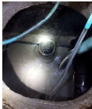
ภาพที่ 4-51 คูตะกอนไขมันและถังเก็บตะกอนในระบบบำบัดน้ำเสีย
