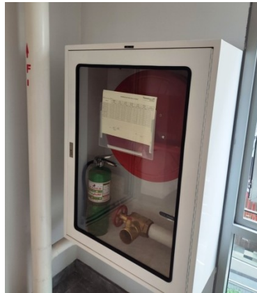
ภาพที่ 4-54 ท่อเย็นและตู้เก็บสายฉีดน้ำดับเพลิงบริเวณส่วนโถงลิฟท์ของอาคารจอดรถ Carpark
