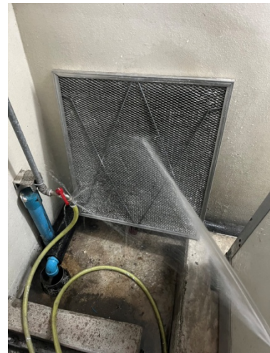
ภาพที่ 4-64 ล้างทำความสะอาดระบบปรับอากาศ และCooling Tower
