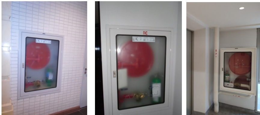
ภาพที่ 4-31 ตู้เก็บสายฉีดน้ำดับเพลิงพร้อมอุปกรณ์ส่วนสรรพสินค้าพาณิश्य์ และส่วนโรงแรม
